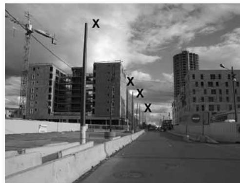
Nouveaux poteaux de trolleybus de la ligne 44 sur l'avenue du Plateau à La Duchère (repérés par les croix sur la photo). Photo : Jean-Marie GUÉTAT
