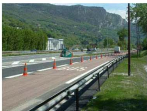
Aménagements des bandes d'arrêt d'urgence (BAU) en voies spécialisées partagées
