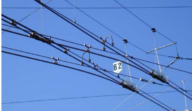
Abb. 6: Mechanische Einlaufweiche von Kummier und Matter für hohe Fahrgeschwindigkeiten [13]
