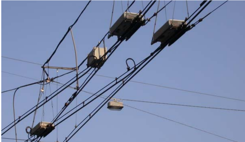
Abb. 7: Auslaufweiche mit gesondert gezeigtem elektrischem Antrieb (in 600 V (oben) und 24 V (unten) Gleichstromausführung, [13]
