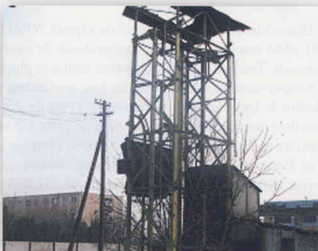
1949 – S-a dat în funcțiune elevatorul electric de alimentare cu cărbuni a locomotivelor.
