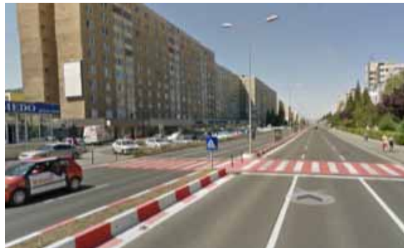
Figura 2.39 Exemple de benzi sonore folosite în apropiere de trecerea de pietoni de pe Calea București
