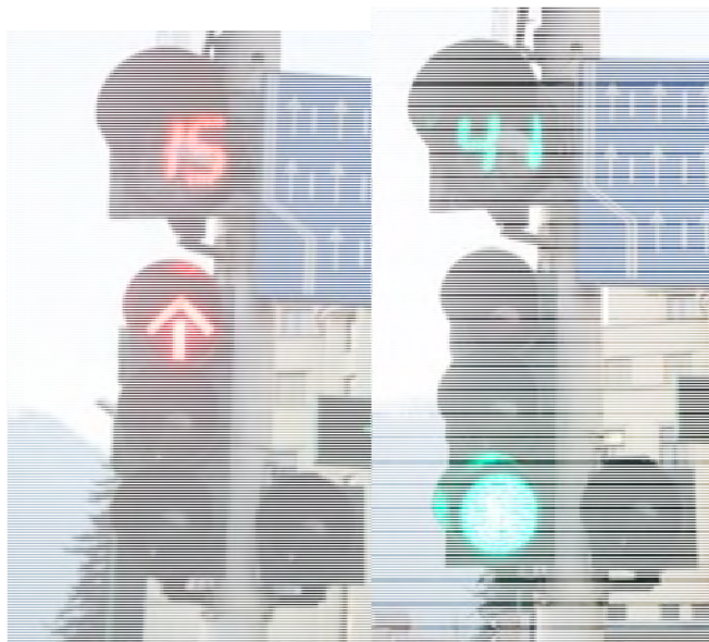
Figura 2.45 Temporizatoare tip „numărătoare inversă” la semafoarele pentru vehicule din intersecția Lunga – N. Iorga
