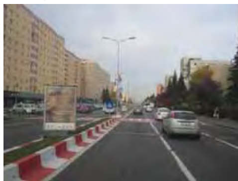
Figura 2.39 Exemple de benzi sonore folosite în apropiere de trecerea de pietoni de pe Calea București
