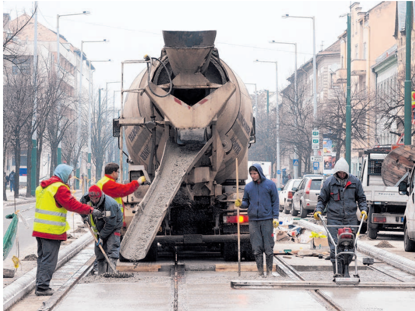
Betonágyat terítenek a kivitelezők az 1-es villamos vonal Kossuth Lajos sugárúti szakaszán.
