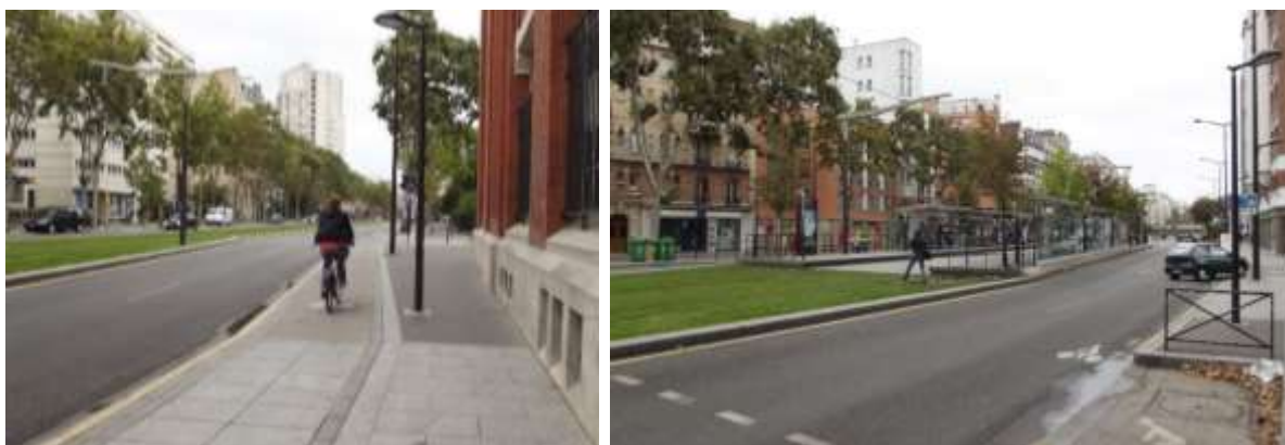
Fig.5 Reamenjarea inelului rutier Boulevards des Marechaux (Paris) odată cu introducerea unei linii de tramvai cu traseu înierbat – reducerea semnificativă a carosabilului (de la 4 la 2 benzi pe sens), lărgirea trotuarelor, crearea unor piste pentru biciclete, plantarea unui număr ridicat de copaci (un al doilea rând al plantației de aliniament)
