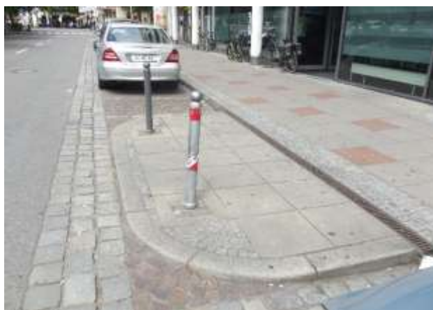
Fig.U44 Avansarea trotuarului până la limita benzii de parcare pe stradă, pentru ameliorarea vizibilității la traversare și micșorarea distanței de traversare
