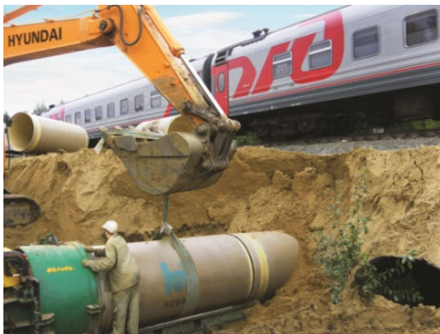
Exemplu de podeț realizat prin metoda Pipe-Jacking
