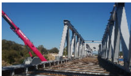
Exemple de realizare a căii la tabliere de tip grinzi cu zăbrele cu cale jos
