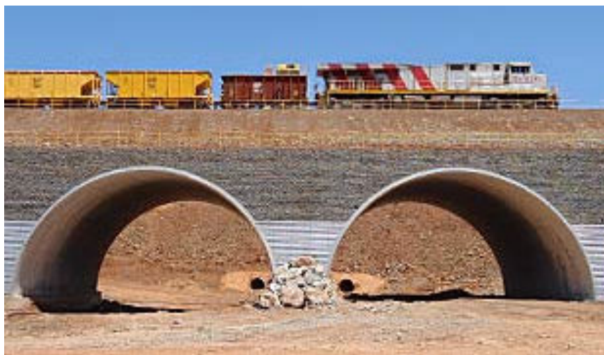
Exemplu de podeț metallic din tablă ondulată
