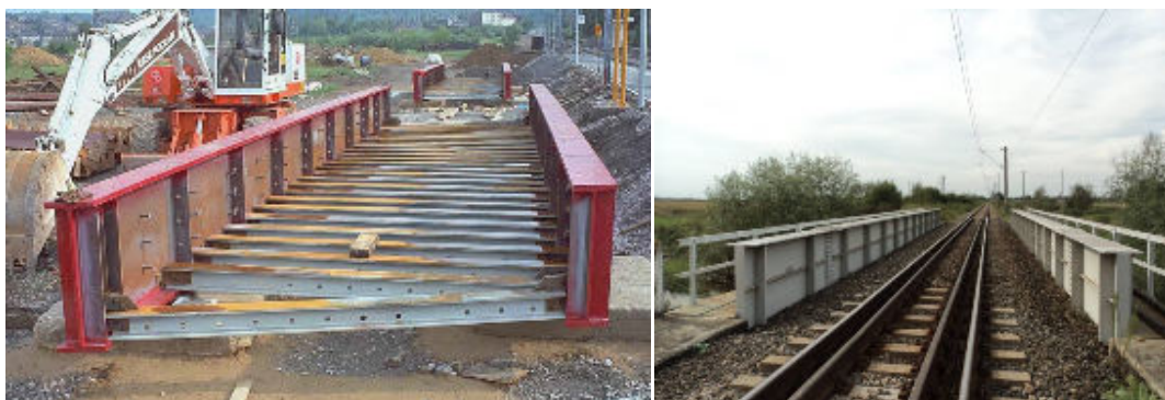
Exemplu de tabliere de tip grinzi cu inimă plină cale jos cu cuvă de balast
