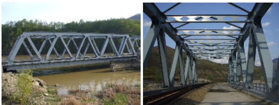
Tablier de tip GZCJ ce asigură continuitatea liniei c.f. Râmnicu-Vâlcea - Podul Olt, peste râul Olt
