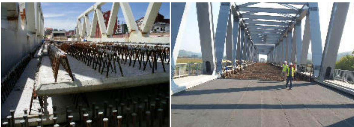
Exemple de tabliere cu cuvă pentru susținerea prismei căii
