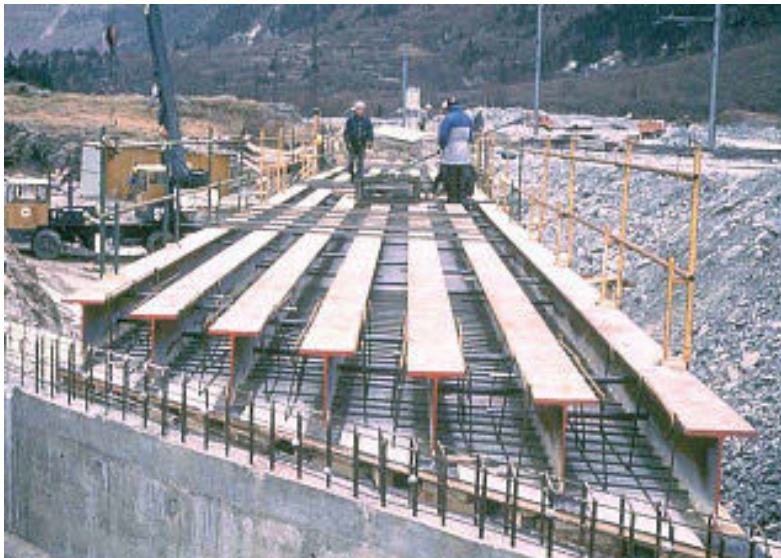
Exemplu de pod oblic, cu tablier din grinzi metalice înglobate în beton
